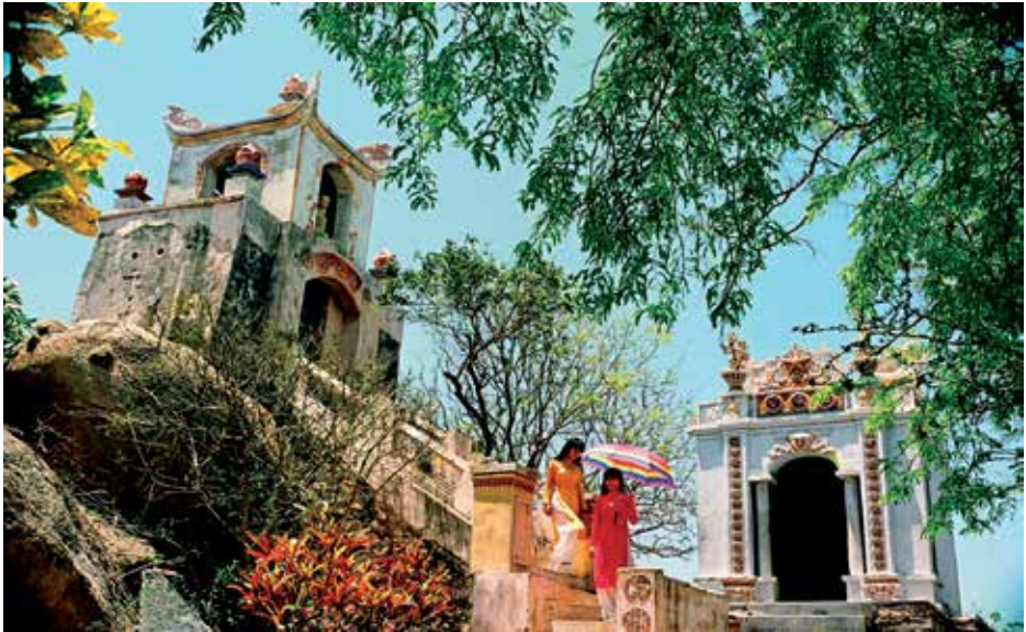
Các hạng mục kiến trúc chùa Cổ Thạch Co Thach Pagoda architectural items
